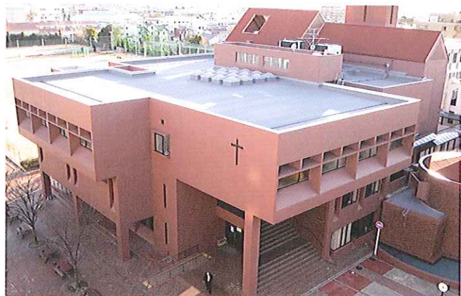
雨漏りが心配された図書館屋上もきれいに整備されました
