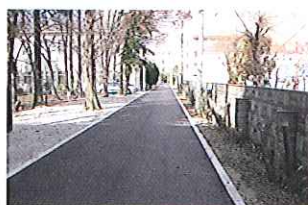
配水管が整理され美しくなったクラブハウス裏の道路
