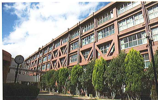
耐震工事が完了した1号館
