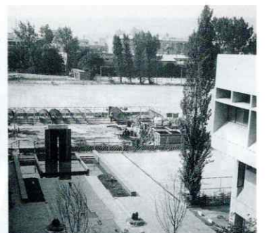
サピエンチア・タワーの建設工事始まる
