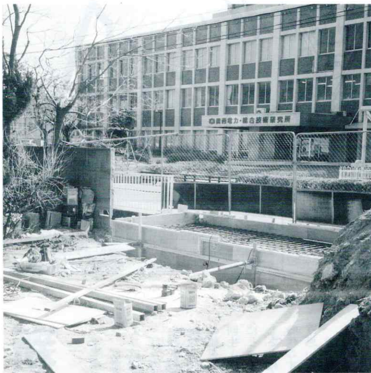
建設が進む南門(後ろは関西電力・総合技術研究所)
