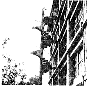
旧館非常階段
